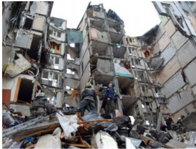
Рис. 1. Фотографія зруйнованого будинку №127
