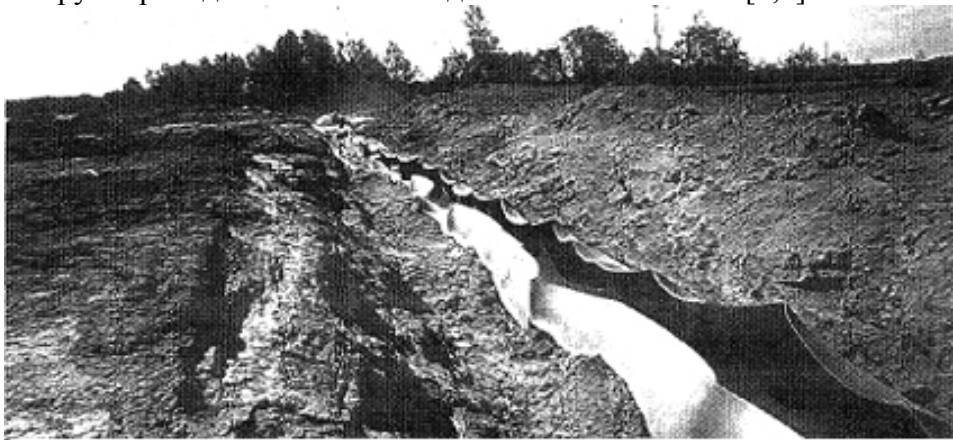
Рис. 2. Аварія на магістральному трубопроводі
