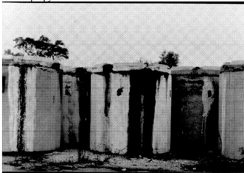
Рис.1. Железобетонные контейнеры с пестицидами, пгт Ольшаница, Киевской области
